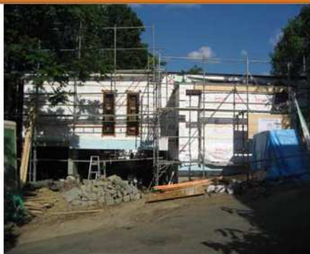
(株)愛夢 新築工事現場(札幌市)
