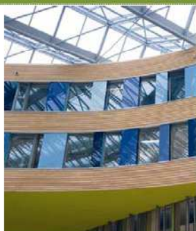
ドイツ連邦環境庁 15,000㎡に及ぶプレハブ木造ファサードと外壁外断熱
