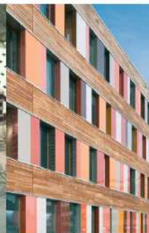
ドイツ連邦環境庁 15,000㎡に及ぶプレハブ木造ファサードと外壁外断熱
