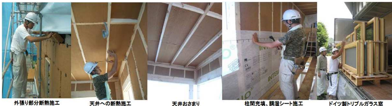
外張り部分断熱施工
