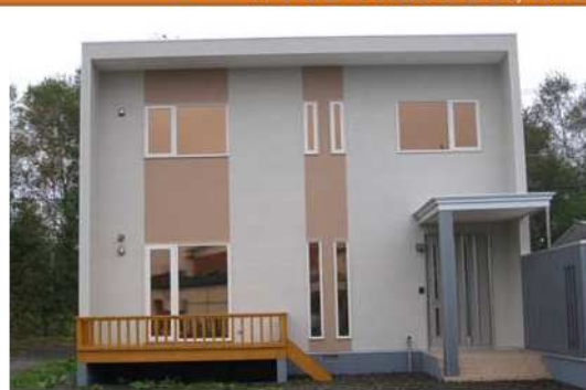
北海塗装(株) 新築工事現場(北海道清水町)
